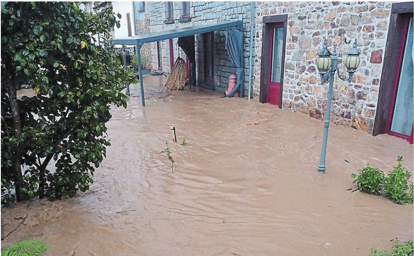
Les habitants du hameau de la Gilaudière, à Landujan, ont été surpris par une rapide montée des eaux, qui a provoqué des inondations dans plusieurs maisons. | PHOTO : PASCAL RAMEN
